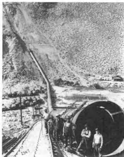
Рис. 5.2.6. Лос-Анджелес получает большую часть воды из долины Оуэнс, находящейся в 300 км севернее города. Вода самотеком прокладывает путь между горами и долинами исключительно под действием силы тяжести. Давление в огромных трубах повышается на спусках и затем используется, чтобы поднять воду на подъемах. На некоторых участках конструкции построенного в 1913 г. акведука должны выдерживать настолько высокое давление, что стенки труб имеют толщину более одного дюйма (2,54 см).
