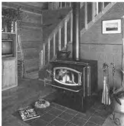
Рис. 7.1.1. Эта дровяная печь распространяет тепло по комнате за счет теплопроводности металлических стенок, конвекции воздуха вокруг печи и излучения от черной поверхности.
