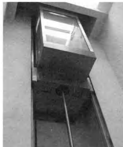
Рис. 4.4.3. Этот лифт поднимается на верхний этаж трехэтажного дома с помощью телескопического гидроподъемника. На самом деле в телескопической системе два плунжера — первый поднимается из подземной части цилиндра, а второй, меньшего диаметра, выдвигается вверх из первого. Если плунжеры выдвинуты полностью и расположены последовательно один над другим, высота, на которую поднимается лифт, почти вдвое больше высоты самого гидроцилиндра.
