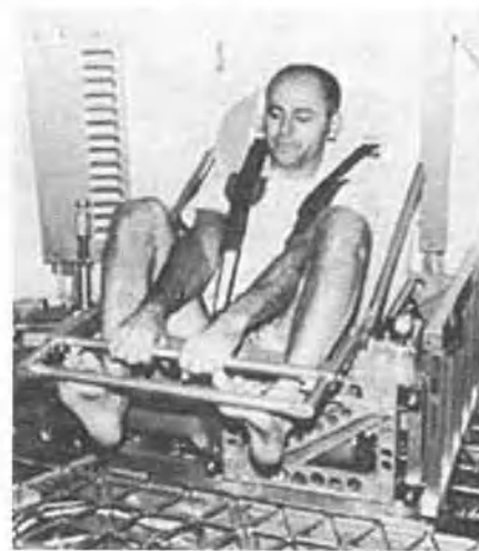
Рис. 3.1.7. И космический корабль, и его команда находятся в одном и том же состоянии свободного падения, поэтому взвесить astronautа обычным способом невозможно. Но с помощью такого аппарата можно воздействовать на astronautа с известной силой и измерить его ускорение.
