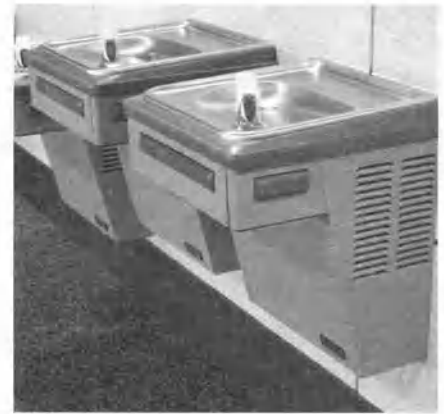
Рис. 8.1.5. В этих питьевых кулерах-фонтанчиках есть встроенные тепловые насосы, которые охлаждают воду. Извлеченное из воды тепло вместе с теплом, произведенным самим тепловым насосом, передается комнатному воздуху через жалюзи на боковой стенке кулера.
