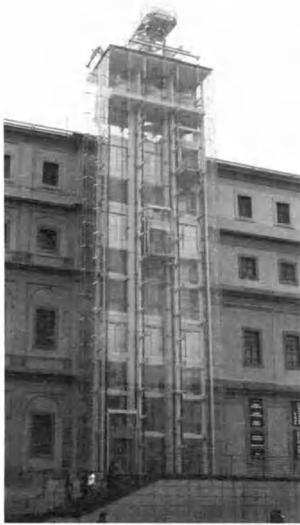
Рис. 4.4.8. Три кабины тросового лифта поднимаются и опускаются в прозрачной шахте, все движущиеся части хорошо видны. Каждая кабина подвешена на четырех металлических тросах, которые уходят в надстройку на крыше здания, где находится большая часть механизмов.
